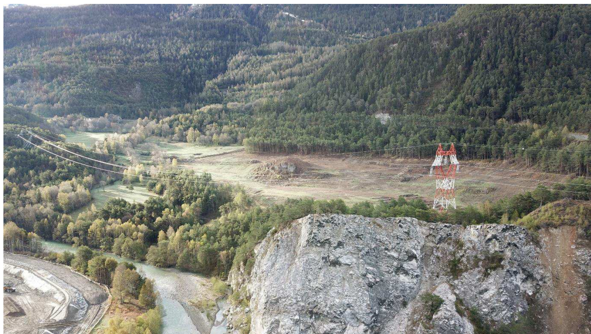
Figure 12 : Vue sur le site de dépôt des Tierces (juillet 2021)
